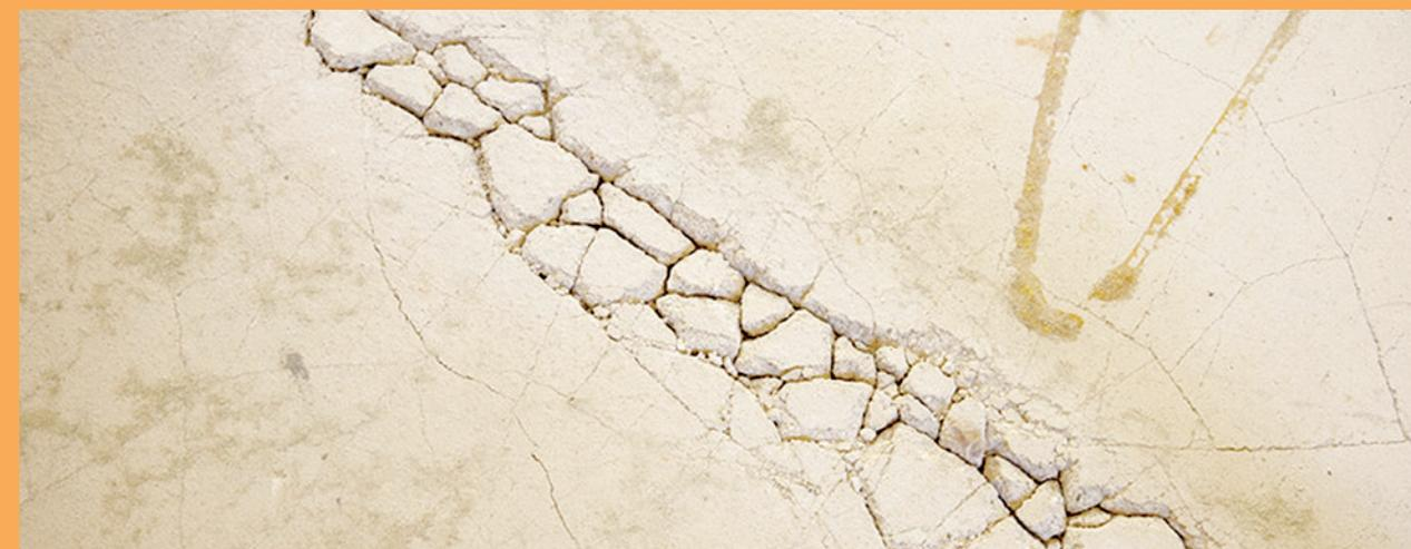
*Lorsque l'on tire sur du tapis en rouleaux tenace pour le décoller, des particules du plancher brut, comme du béton de plâtre, peuvent rester collées sur le revêtement et ainsi exiger d'importantes réparations avant la pose du nouveau revêtement. Une fois le sol réparé, il vaut mieux opter pour un système d'installation sans colle afin d'éviter tous ces tracasseries à l'avenir.*
